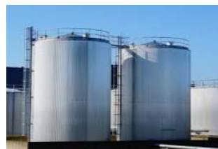
硫化水素による 腐食の防止がしたい
